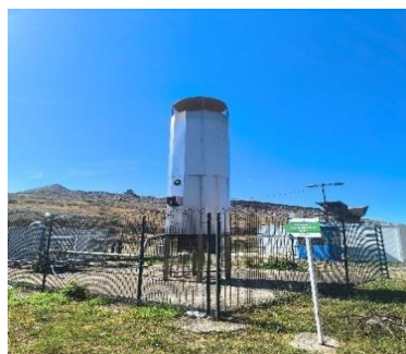
Slika 15 Eko baklja 800 m 3 /h 150m 3 /h
