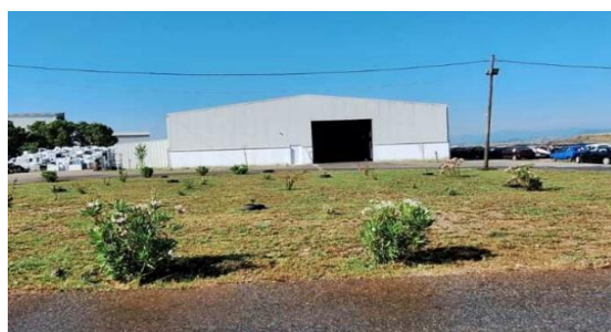
Slika 19 Pogon za reciklažu otpadnih vozila i EE otpada
