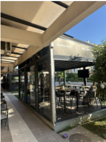
Prolaz uz fasadu objekta i odnos terase prema postojećoj betonskoj nadstrešnici
