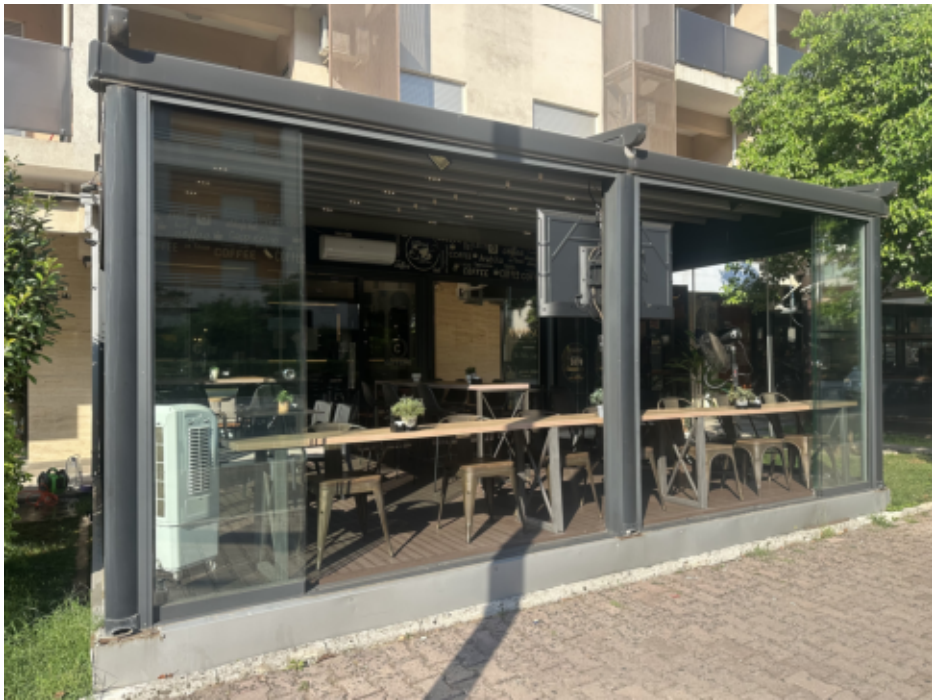
Prednji izgled sa ulice – tri polja bezokvirnih kliznih panoa, srednje polje otvoreno; vidljiva tenda i LED rasvjeta
