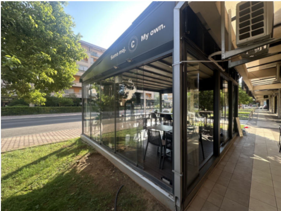
Ugao terase – vijenac sa reklamnom trakom, vertikalna oluka, obodna sokla i podest od WPC daske
