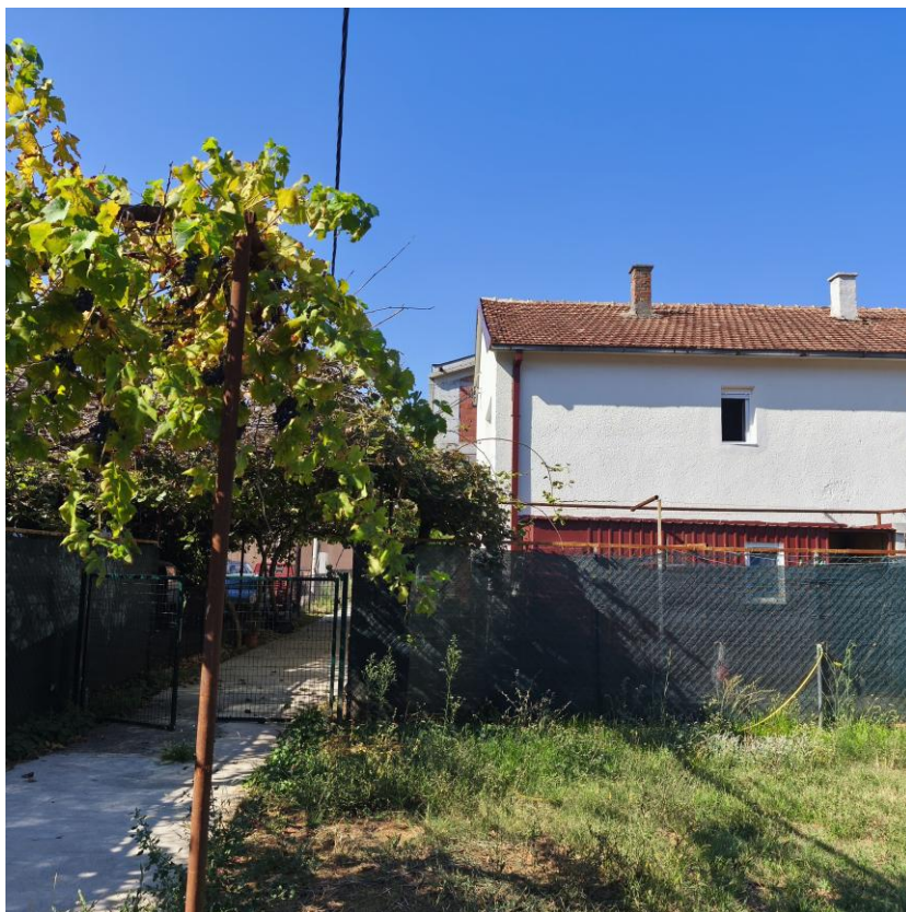
Sl3. Objekat 2 koji se je predviđen za rušenje
