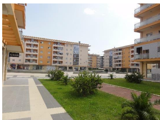
Slika br.2.16c. Primjer zidanih stambenih objekata sa AB ojačanjem (lijevo) i objekata sa ramom od prenapregnutog betona – izgrađenih prije 1981. godine (desno) (NERA, 2014).
