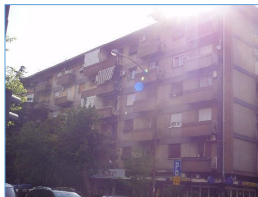
Slika br.2.16b. Primjeri zidanih objekata sa betonskim podovima na teritoriji Glavnog grada Podgorica (NERA, 2014).
