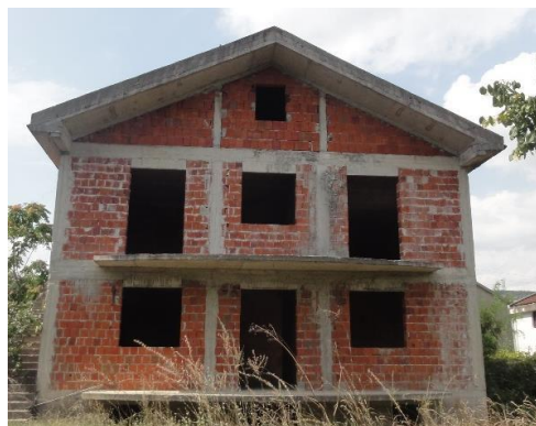
Slika br.2.16b. Primjeri zidanih objekata sa betonskim podovima na teritoriji Glavnog grada Podgorica (NERA, 2014).
