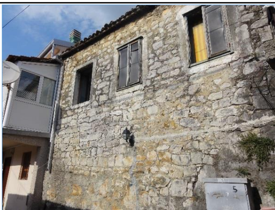
Slika br.2.16a. Primjeri gradnje zidanih objekata tesanim kamenom u opštini Podgorica (NERA, 2014).
