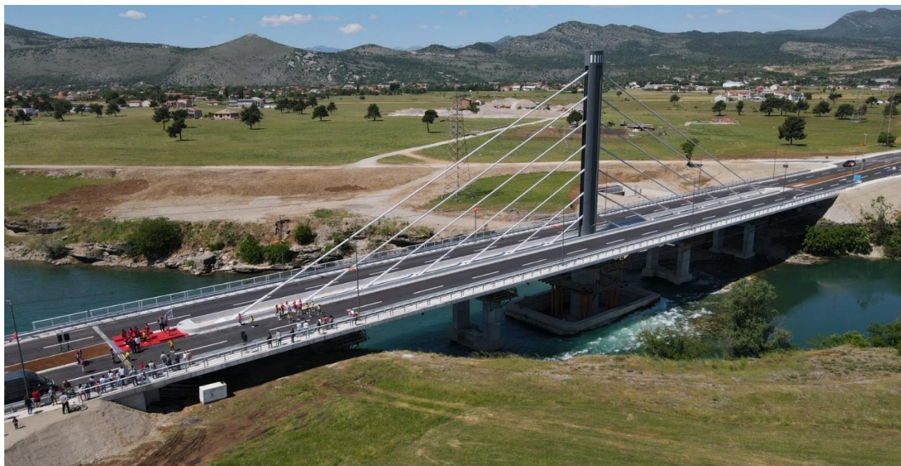
Slika br.7. Most “Luča” na jugozapadnoj obilaznici koja povezuje magistralne pravce koji povezuju Glavni grad sa Cetinjem i Petrovcem
