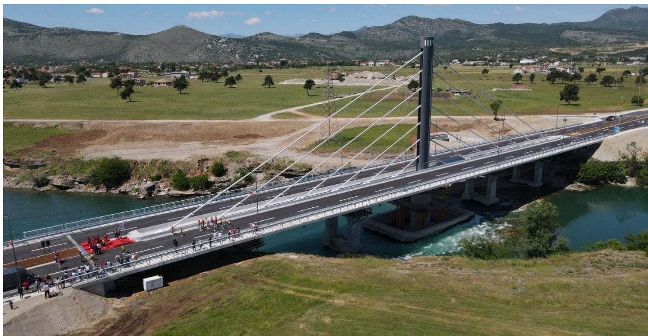
Slika br.9. Most “Luča” na jugozapadnoj obilaznici koja povezuje magistralne pravce koji povezuju Glavni grad sa Cetinjem i Petrovcem
