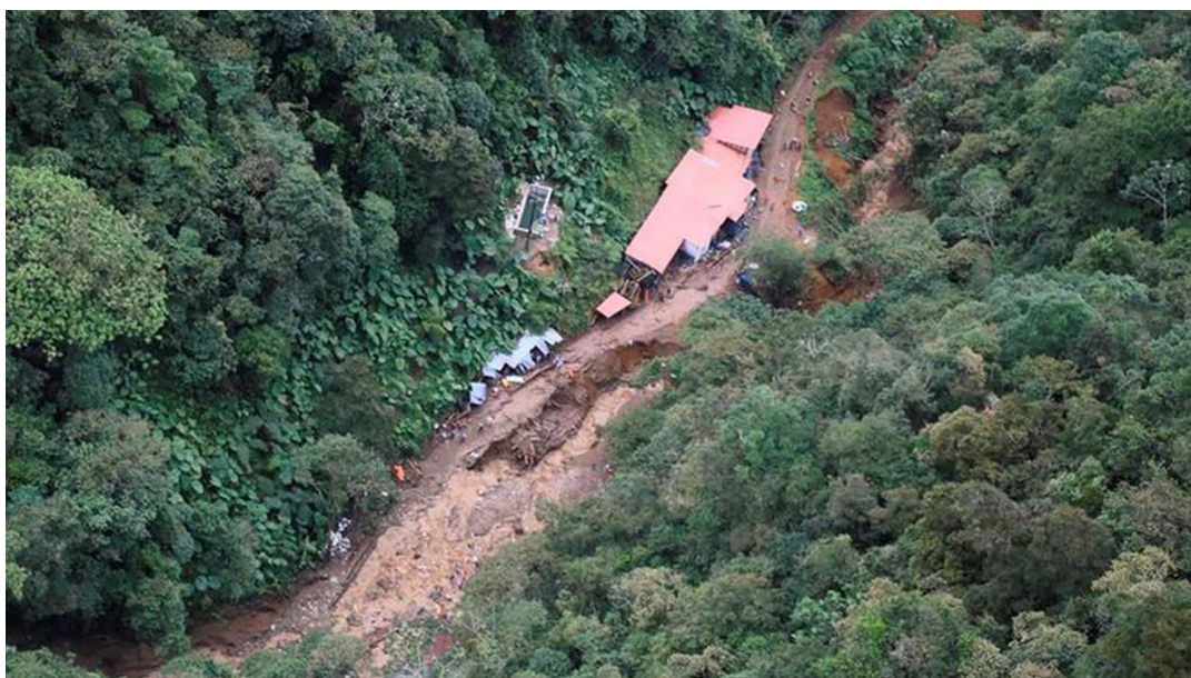
Slika br.2.6. Klizište u Kolumbiji
