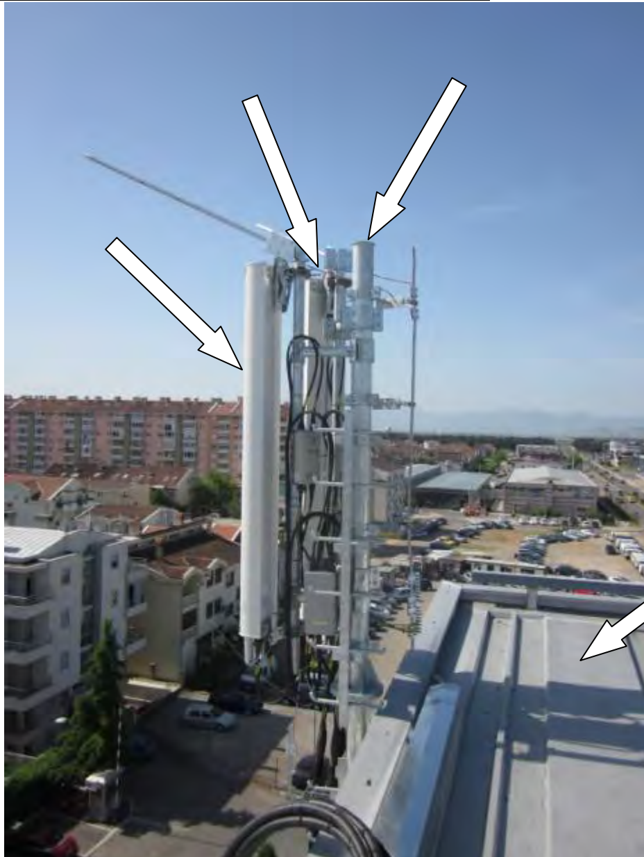
Slika 3 Stub sa pripadajućim distancerima i podložnom pločom koji se nadograđuje Panel antene (1 i 2 sektor) koje se premeštaju na nadograđeni segment Položaj tačke oslanjanja kosnika na betonsku kocku
