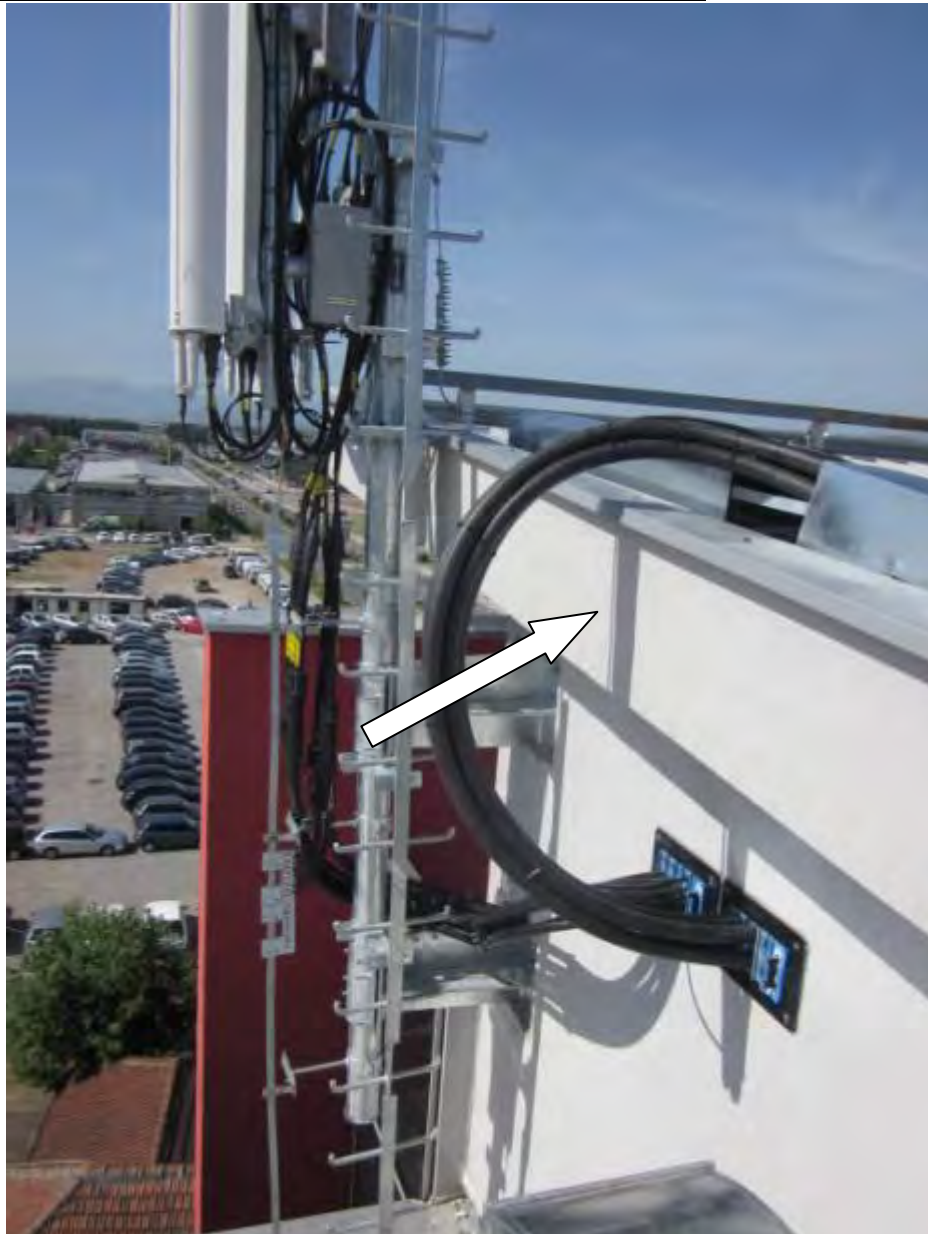
Slika 4 Položaj tačke oslanjanja kosnika na ispust ploče
