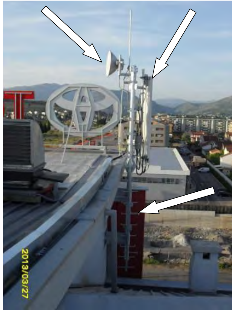
Slika 2 Stub sa pripadajućim distancerima i podložnom pločom koji se uklanja Panel antena (1 sektor) i link antena koje se premeštaju na nadograđeni nosač
