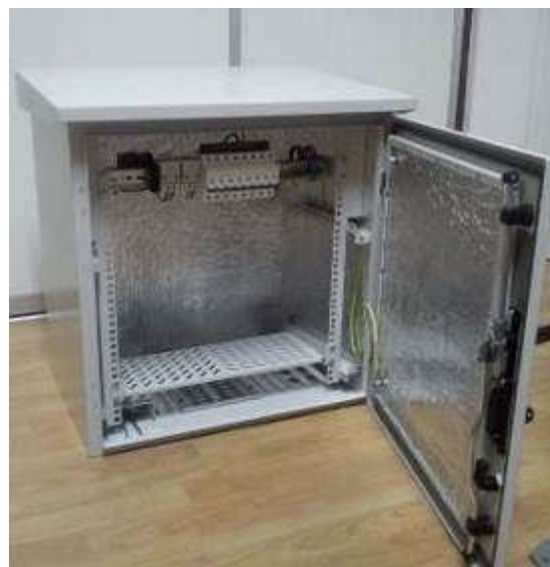
Slika 2.5. Izgled ormara sa ventilacionim sistemom u kojem će biti smještena TK oprema
