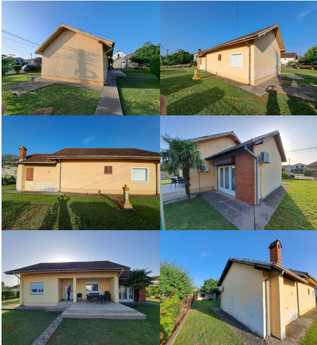
Fotografije postojećeg objekta na KP3205 čija je rekonstrukcija i dogradnja planirana idejnim rješenjem
