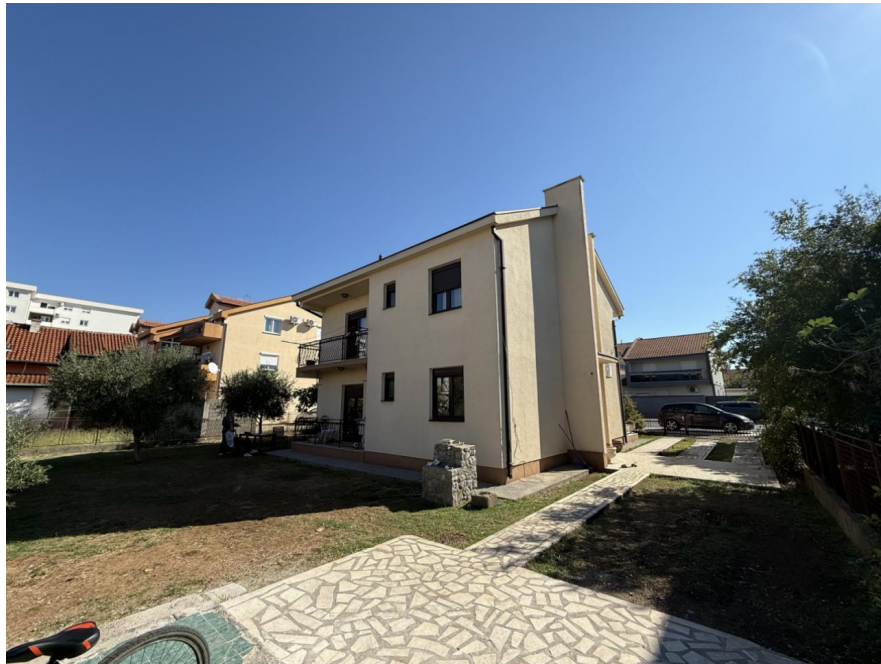
Slika 4. Bočna fasada postojećeg objekta
