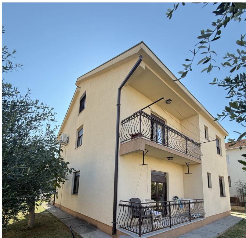
Slika 3. Bočna fasada postojećeg objekta
