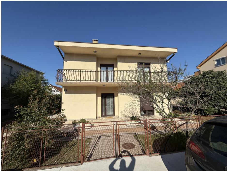
Slika 1. Prednja fasada postojećeg objekta
