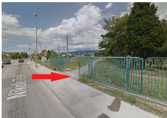
Prikaz makadamske saobraćajnice ka vodoizvoru
