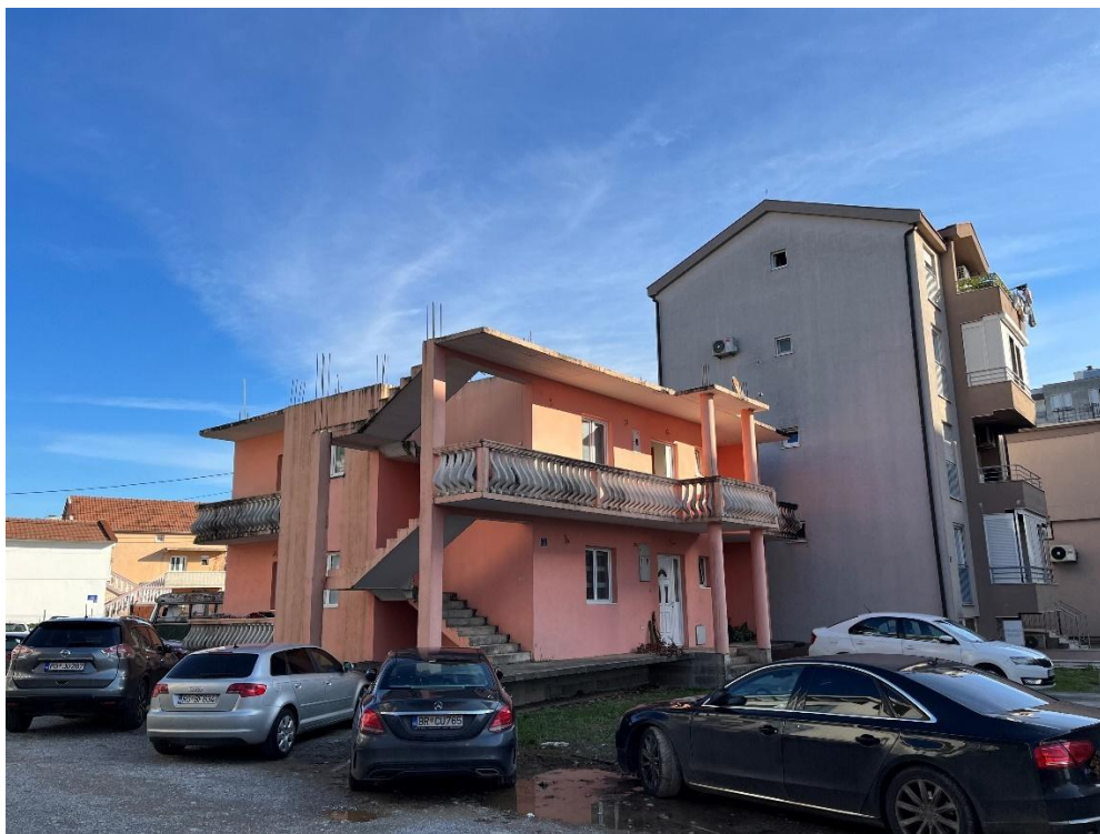
Fotografija 3 – postojeći objekat
