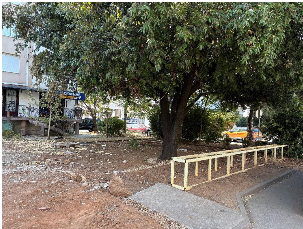
Slika 3: Fotografija postojećeg stanja predmetne lokacije
