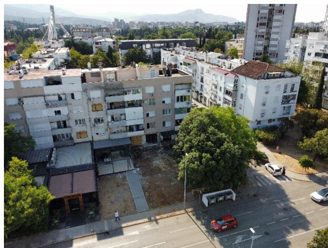
Slika 2: Snimak iz drona postojećeg stanja predmetne lokacije
