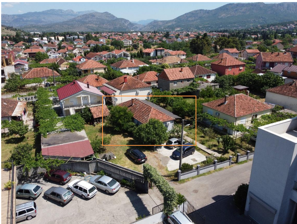
Fotografija 2 – postojeće stanje lokacije sa naznačenim postojećim objektom, predviđenim za uklanjanje
