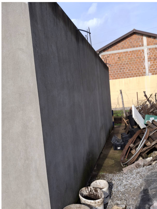
Fotografija br. 1: Sjeverna fasada objekta.
