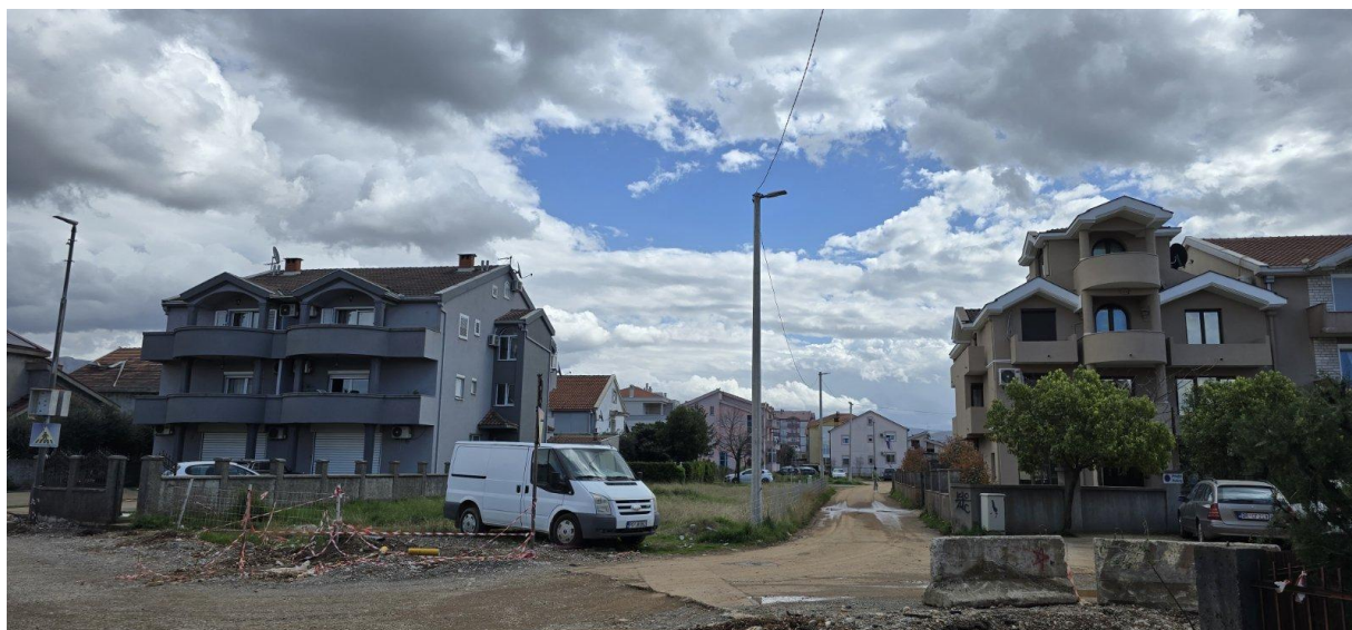
Sl.1. – Postojeće stanje
