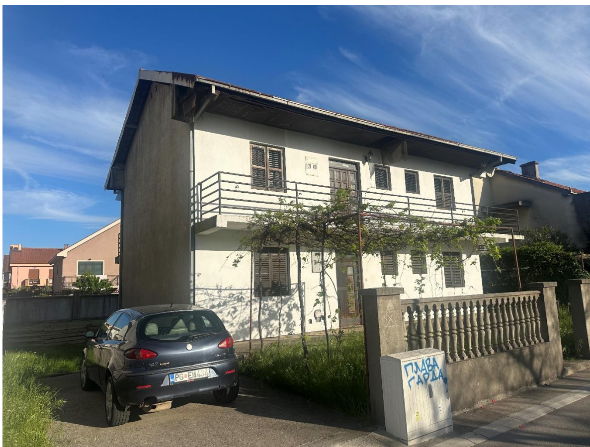
Objekat na lokaciji koji je predviđen za rušenje
