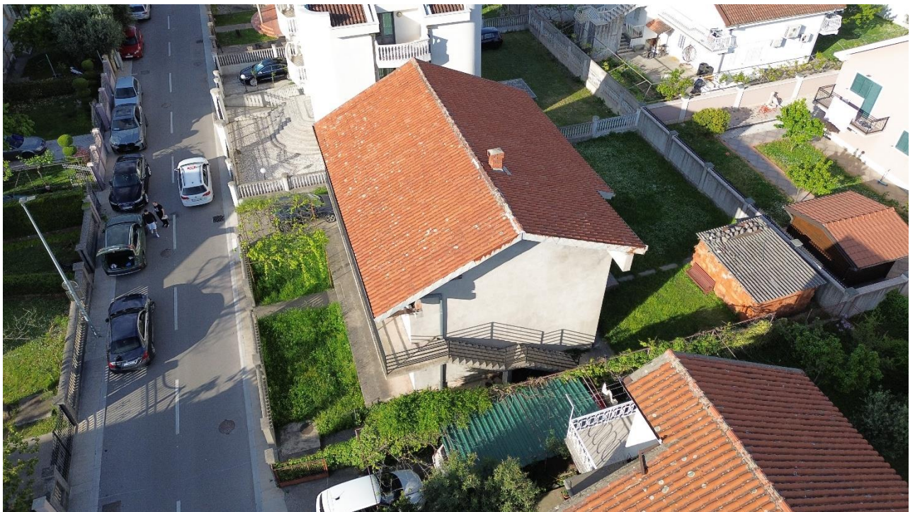
Postojeće stanje lokacije
