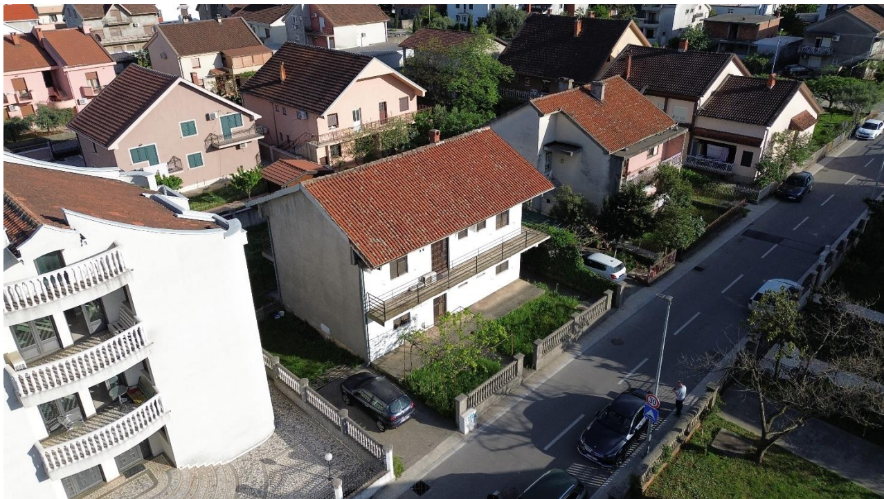
Postojeće stanje lokacije
