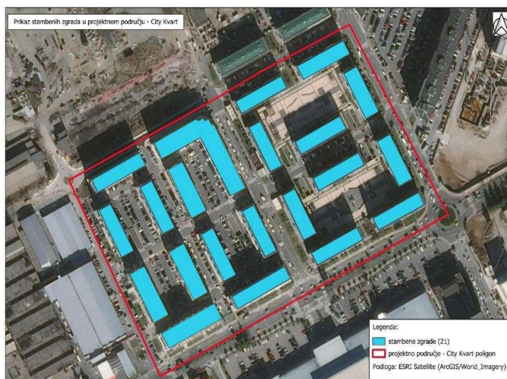
Slika 7: Stambene zgrade u naselju City kvart;
