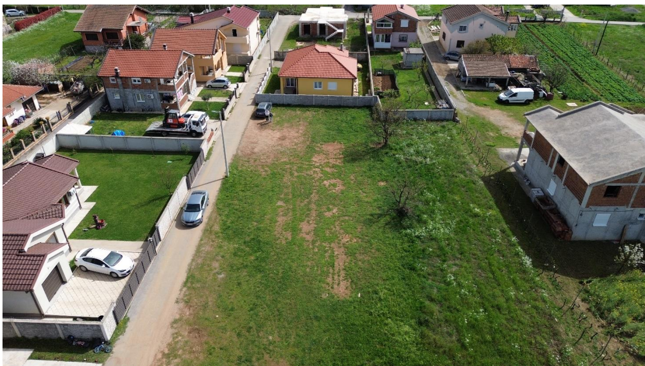
Lokacija za izgradnju objekta
